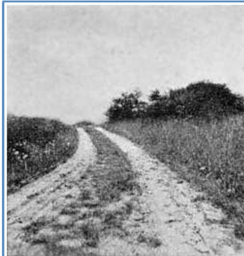
Abb.16: Ein Einzelblick auf den in Abb. 15 dargestellten Teil der Hochstraße.
