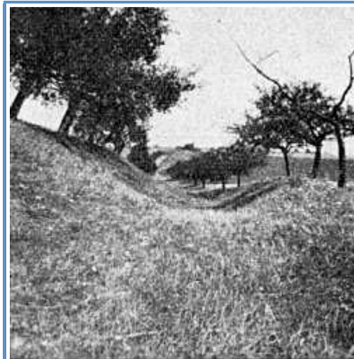
Abb.6: Die hier zum Feldweg vergraste Hochstraße beim Aufstieg, als Markungsgrenze zwischen Hagenbach und Heuchlingen. Im Hintergrund zieht der Weg weiter hoch als Markungsgrenze Untergriesheim (Jagst) links und Willenbach-Ödheim (Kocher) rechts.
