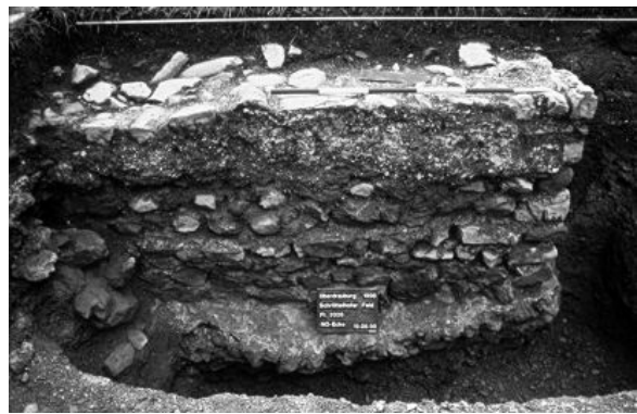
3. Oberdrauburg, Schrötterhofer Feld; NO-Ecke des Gebäudes, außen; an Unterkante überhängender Fundamentabstrich (Aufn. R. Franke).
